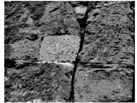
An einer Felswand der Anlage bei Schmie sehen einige quadratische Teile aus, als ob sie künstlich in die Wand eingesetzte Blöcke seien, zumal sie sich farblich von dem umgebenden Felsmaterial unterscheiden.
