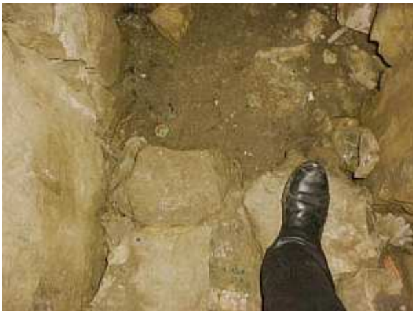
Die Stufe im Knickgang. Links neben der Stufe die in den Stein eingelassene verrostete Türangel. Unten: Die Türangel auf der rechten Seite des Zuganges.
