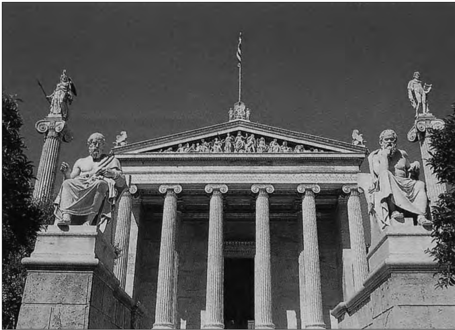
Bild 2: Aus solchen repräsentativen Gebäuden im klassischen Stil sollte die Stadtmitte der neu gebauten Stadt Athen bestehen. Nur einige wenige der Bauvorhaben wurden auch realisiert, wie dieses Gebäude der Akademie der Wissenschaften (erbaut 1859-85).
