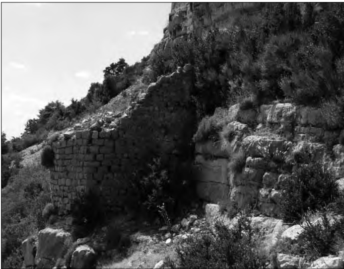
Bild 11: Bauten unterhalb von Saint-Trophime.
