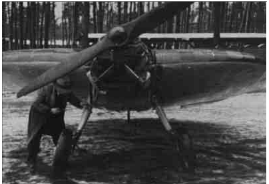
Abb. 1: Die „Flugscheibe“ A. S. 6 des Konstrukteurs Arthur Sack war ein herkömmliches Flugzeug, das anstatt Tragflächen einen scheibenförmigen Körper besaß. Es wurde durch einen konventionellen Propellermotor angetrieben, hatte jedoch sehr schlechte Flugeigenschaften. Von der A. S. 6 wurde nur ein Modell gebaut, das bei einer Bruchlandung zerschellte.
