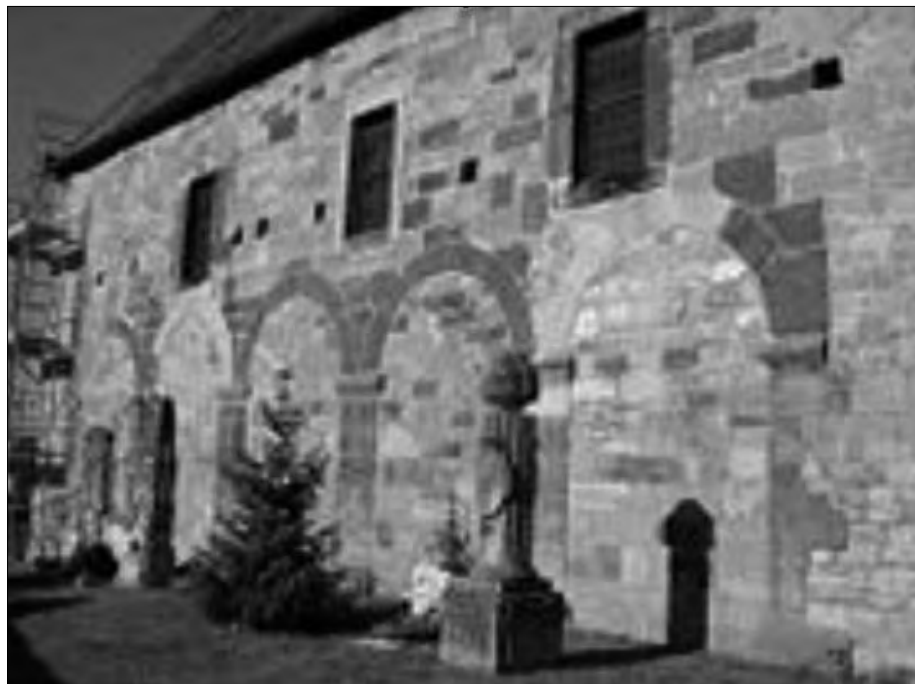
Nikolaikirche Oberndorf/Thüringen. Baubeginn erste Hälfte 12. Jahrhundert (1170 erster Umbau). Vermauerte Arkaden und barocke Fenster an der Südwand (Wikipedia)
