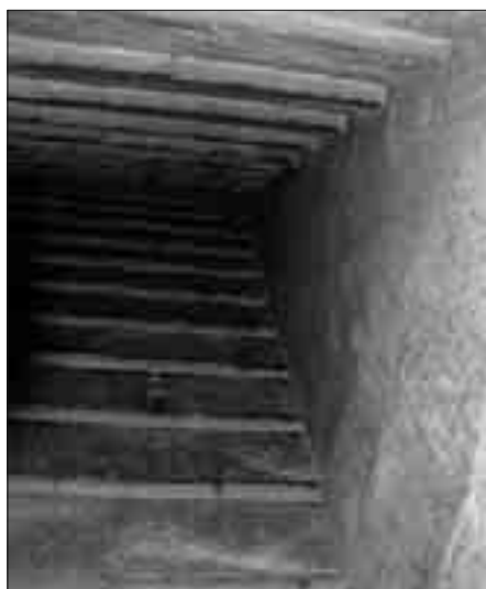
Ein Blick nach oben in der ersten „Vorkammer“ zeigt das fantastische zwölf Meter hohe Kraggewölbe.
