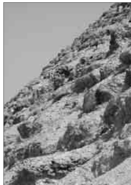
Aus der Nähe betrachtet zeigen die Steinblöcke der Außenseite einen erschreckenden Erosions-Verfall.
