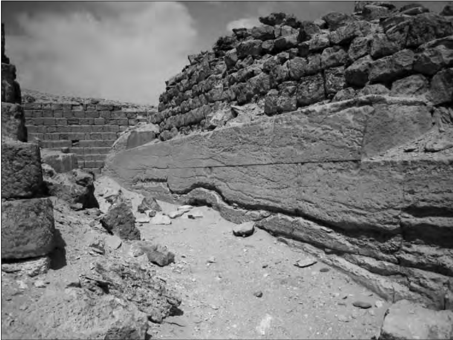
Hier wurden in den unteren Lagen riesige Steinblöcke verbaut, die neben der Wassererosion eine weitere Eigenschaft zeigen: Die Felsstrukturen setzen sich über mehrere Blöcke hinweg fort! Das heißt, dass die Blöcke in derselben Reihenfolge, wie sie im Steinbruch gebrochen worden sind, hier wieder zusammengesetzt wurden! Man beachte weiterhin, dass zwischen den einzelnen Blöcken nur Millimeter kleine Zwischenräume bestehen, im Gegensatz zu den darüber aufgetürmten kleineren Steinblöcken.
