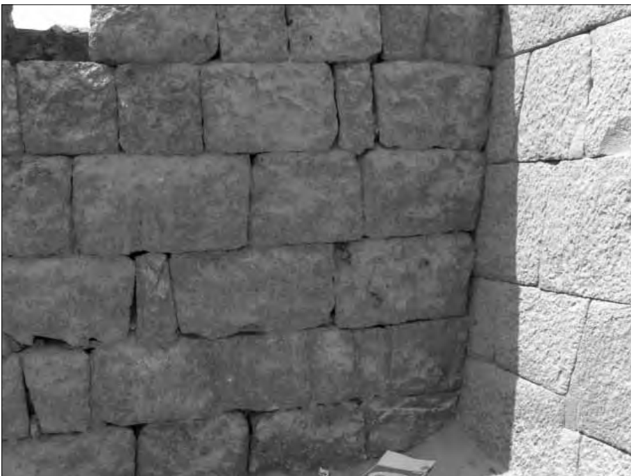
Zwei Mauern, zwei Bauarten. In der linken Mauer sind die Steine relativ einfach zusammengesetzt, in der rechten hingegen fast fugenlos.
