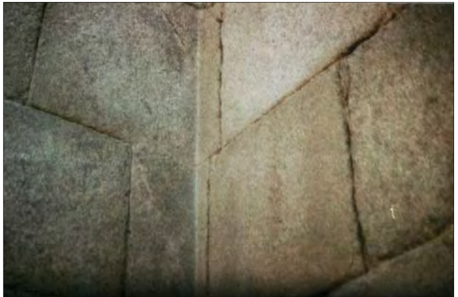
Bei der Verarbeitung der Granitblöcke wurden Ecken und Kanten ausgespart. Man beachte die Eckenverfugungen.
