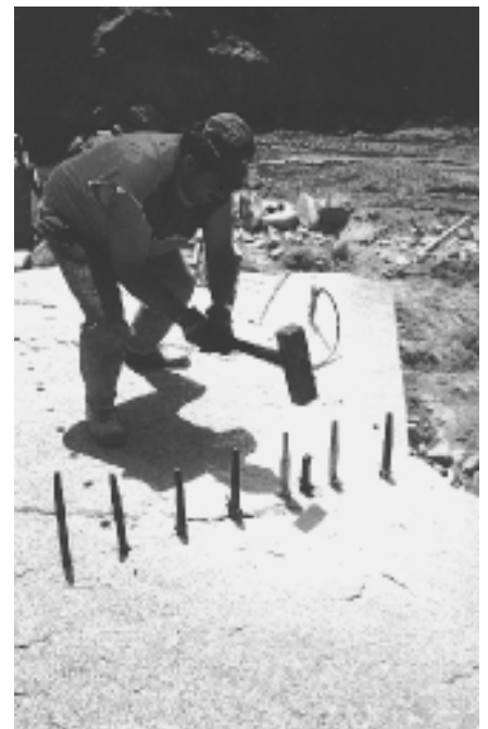
Abb. 5: Beim Einschlagen der Keile (Foto: © Löhner)
