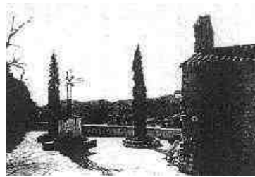
Abb. 3: Kreuz an der Stadtmauer der Bergstadt Baux (Frankreich)
