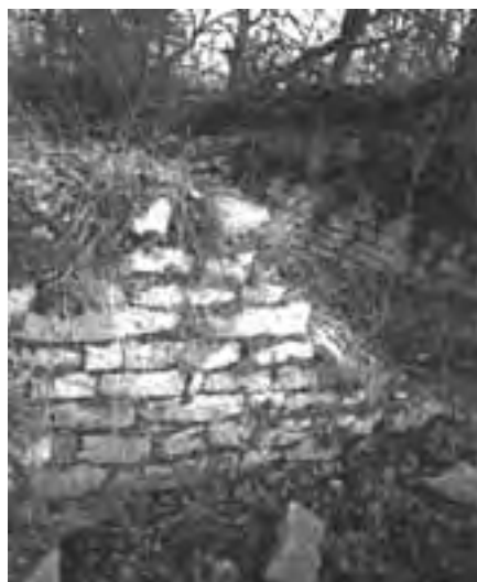
Teil der ehemaligen Burganlage auf dem Berggrat.
