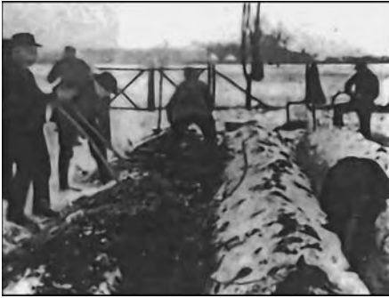
Letzte Kontrolle: „Graben fertig!“ (Original-Bildtext)
