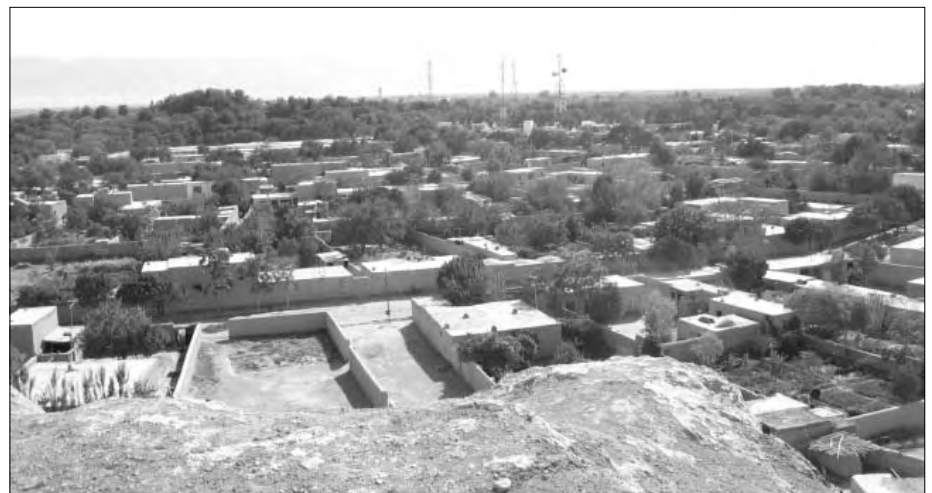
Abb. 2: Blick auf die Hauptstadt von Baktrien (Balkh).
