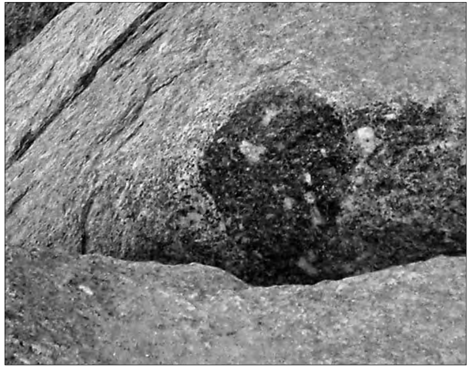
Bild 3: Auch hier eine Reparaturstelle mit Mörtel! (Mykerinos-Pyramide, Gizeh).
