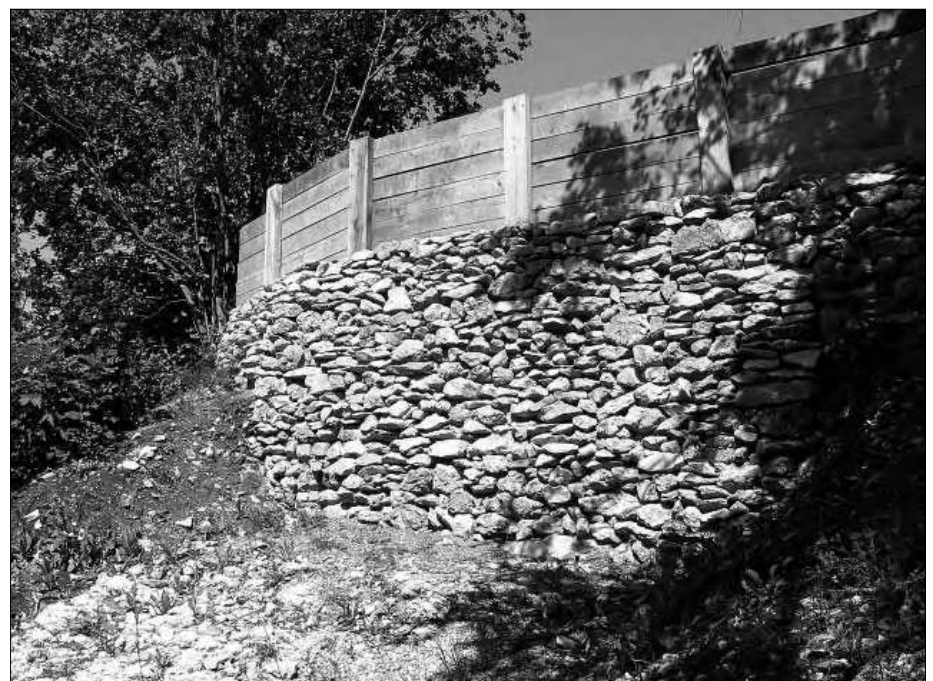
Bild 6: Rekonstruktion der Befestigungsmauer
