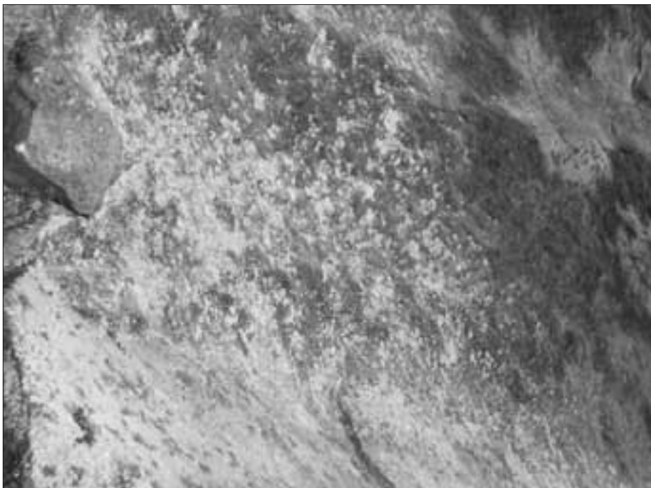
Abbildung 16: Scharrierungen oberhalb der glatten Bank
