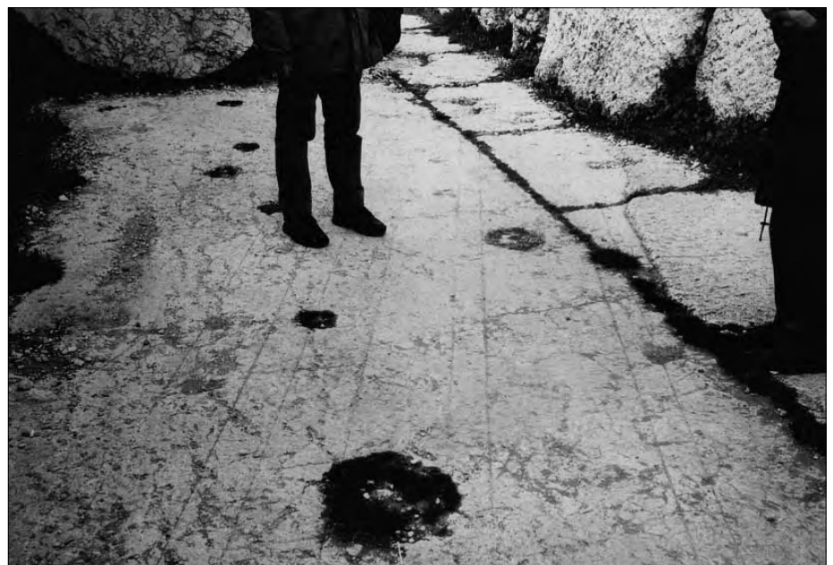
Abb. 6: Kratzspuren, die vermutlich einer der gewaltigen Steinquader beim Transport auf dem gebauten Untergrund hinterließ.
