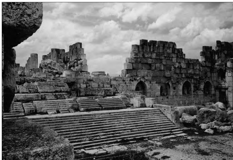
Abb. 1: Die Freitreppe ist aus wenigen Monolithen hingesezt. Arbeitersparnis? Oder Vorsorge gegen Erdbeben?
