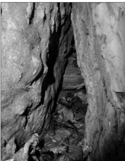
Bild 17: Hohlraum hinter der Steinplatte.
