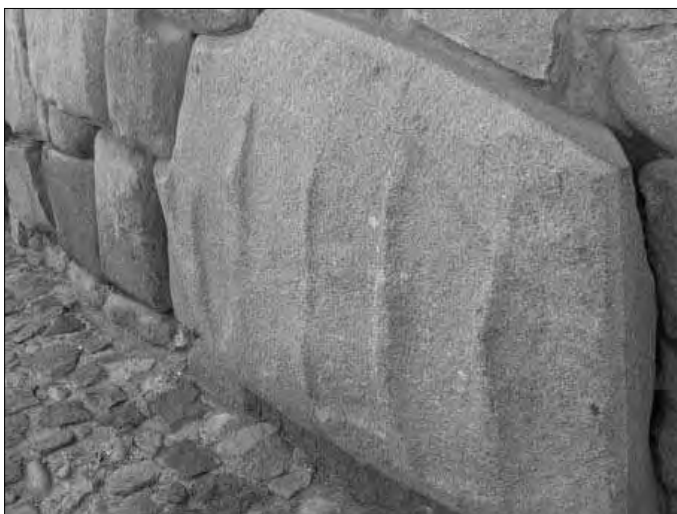
Cuzco, Inkastraße: An diesem verbauten Andesit-Steinblock erkennt man sehr gut die angewendete „Eislöffelchen“-Schabemethode an weichem Gestein.
