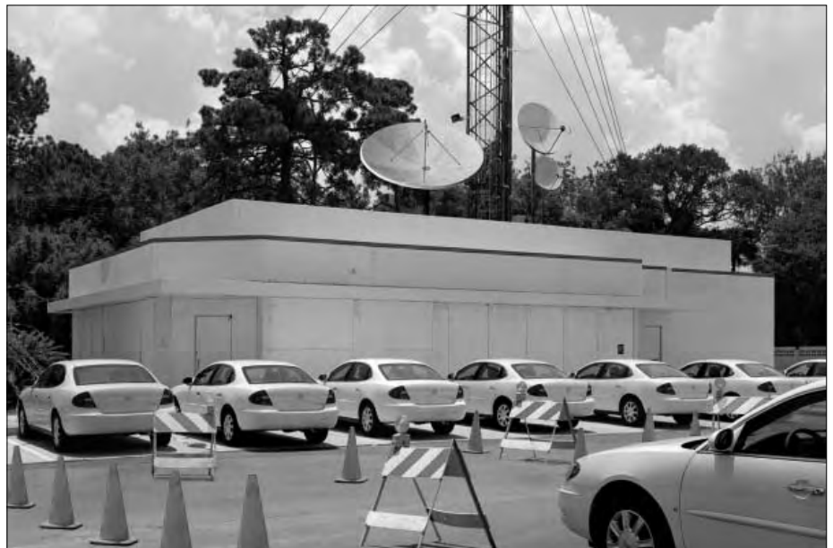
Oberirdischer Teil einer militärischen Untergrundbasis.
