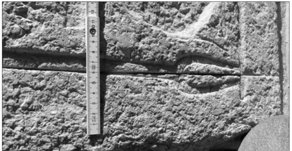
Sauber gearbeitete horizontale Kerbe in einem Granitblock (Karnak-Tempel, Hauptdurchgang)
