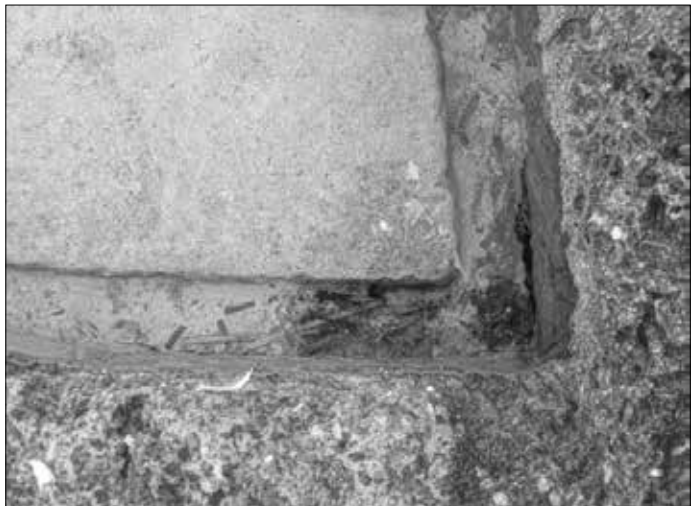
Abb. 7 und 8: Beispiele, wie sauber die Ecken ausgeschnitten wurden.
