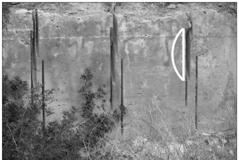
Abb. 10: Mauer, herausgeschnitten aus gewachsenem Fels. Rechts zum Vergleich: Diese Größe muss das Sägeblatt gehabt haben, Durchmesser ein Meter!
