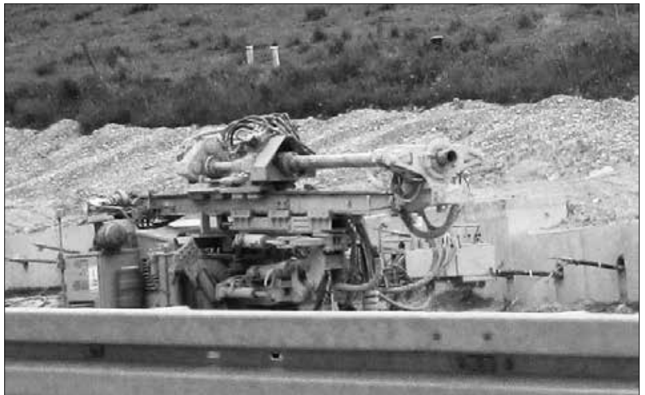
Hier eine solche Maschine im Straßenbau. Es werden Kernbohrungen in die (rechts im Bild) Beton-Stützwand getrieben, um dort Verankerungen einzubringen. Warum macht man das nicht mit einfacheren Mitteln, wie es doch die alten Ägypter angeblich machten?
