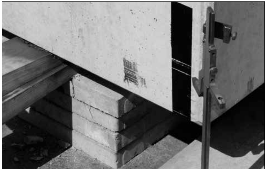
Nach längeren schweißtreibenden Schlägen war der schwere Betonblock einige Zentimeter angehoben, wie man an der schwarzen Markierung erkennen kann.
