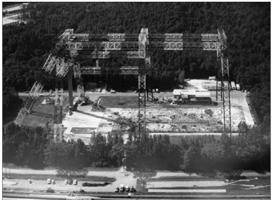
Der große Traversenkran mit darunter nachgebildeter „Mondlandschaft“ im Langley Research Center der NASA.
