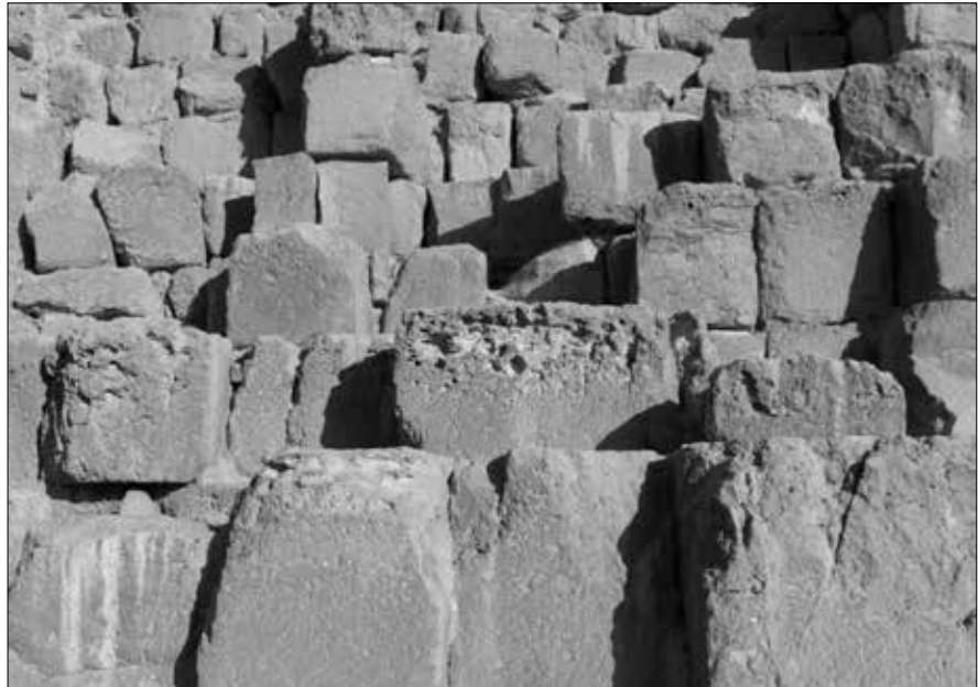
Cheopspyramide (Westseite): Von wegen gleichmäßige Steinblöcke! Es wurden munter alle möglichen Steinblöcke verbaut: kleine, große, dicke, dünne!
