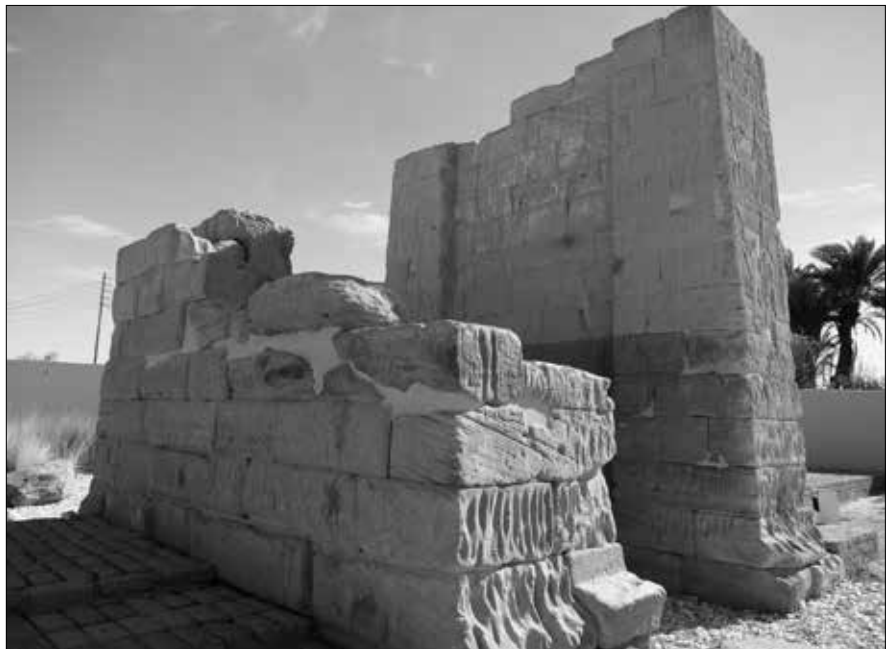
Das ehemalige Eingangstor (Innenseite).
