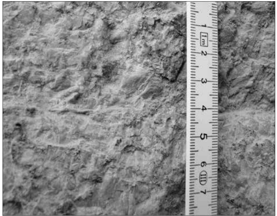
Auch hier befindet sich die Trennfuge bei Zentimeter 4. Unmittelbar neben dem Maßstab blockübergreifende Strukturen (Chephren-Taltempel).
