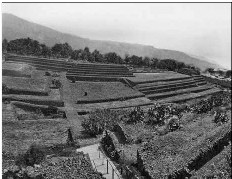
Bild 2: Die Gesamtanlage von Güimar.
