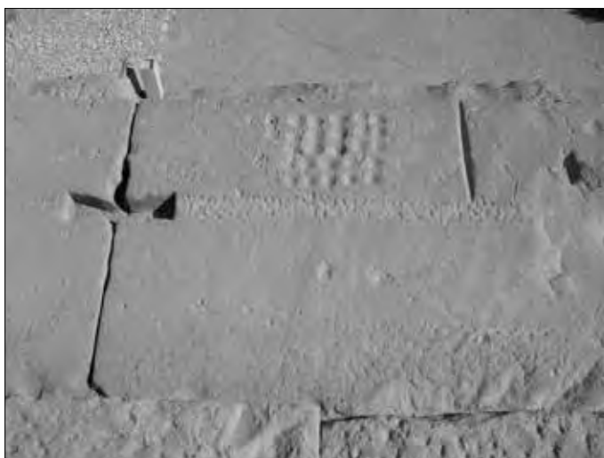
Klammer-Aussparungen (links) in Deir el-Schalwit (Isis-Tempel). Rechts: in Deir al-Madina (Hathor-Tempel).
