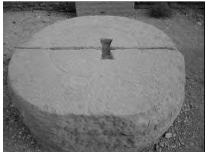
Klammer-Aussparung im Merenptah-Tempel (Luxor-Westbank)-
