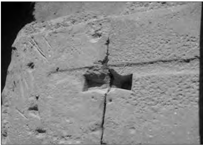
Klammer-Aussparungen in Deir el-Schalwit (Isis-Tempel).
