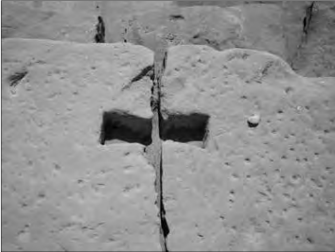
Klammer-Aussparungen in Edfu (Horus-Tempel).
