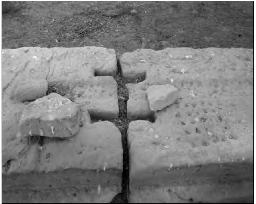
Beispiel für Klammer-Aussparungen, hier im Al-Tud-Tempel in Qena (Luxor-Westbank).
