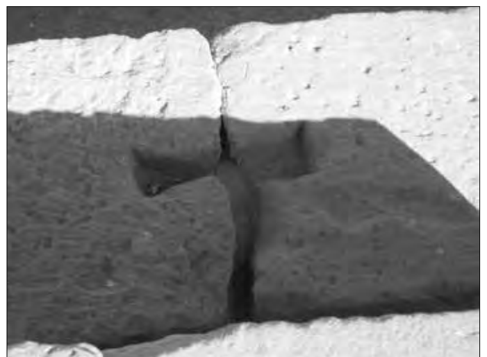
Klammer-Aussparungen (links) in Deir el-Schalwit (Isis-Tempel). Rechts: in Deir al-Madina (Hathor-Tempel).
