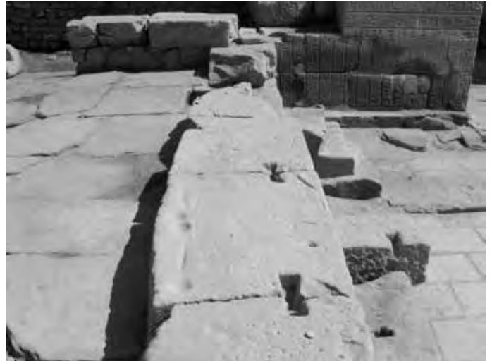
Klammer-Aussparungen in Edfu (Horus-Tempel).
