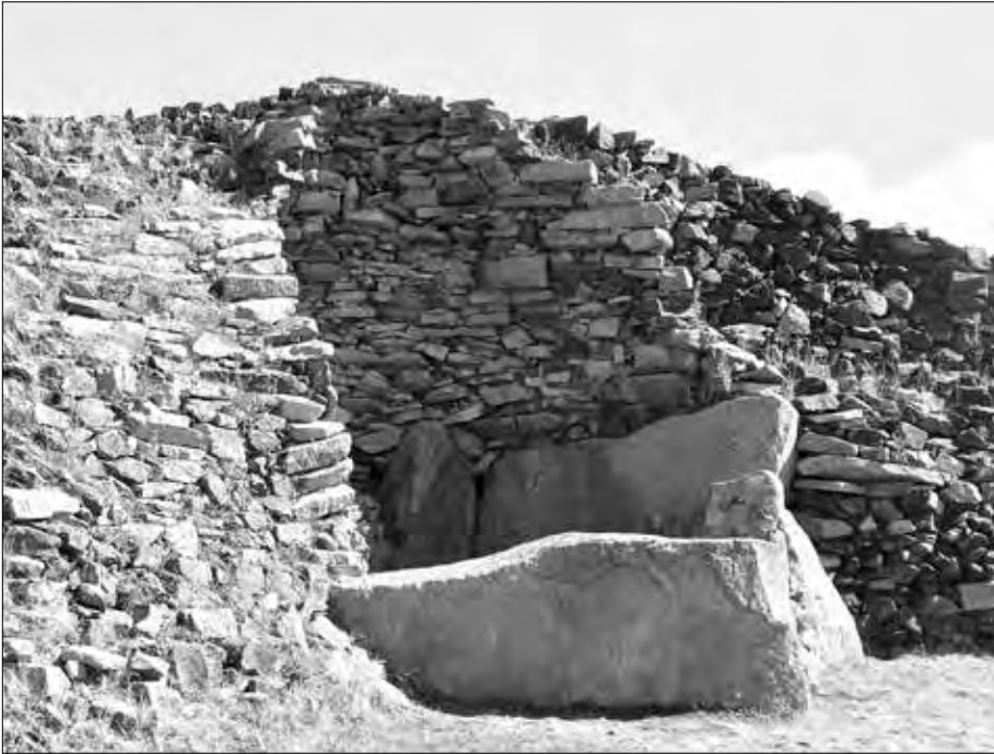
Bild 9: Dolmenkammer mit Gewölbedecke.
