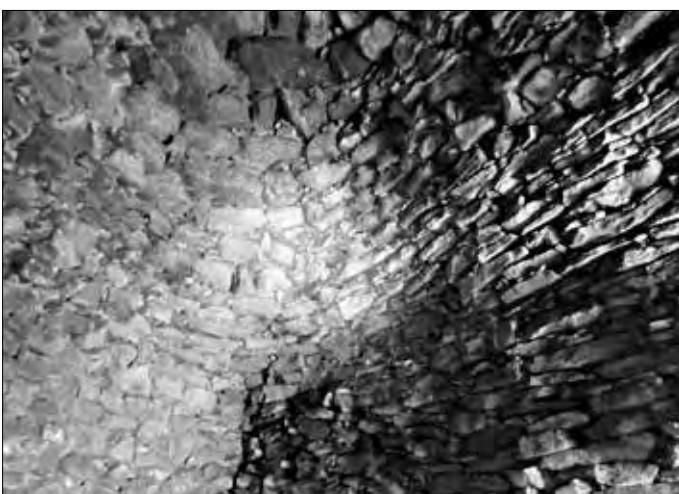
Bild 21 (links): Kraggewölbe im Raum rechts. Bild 22c (rechts): Eingang zur Megalithanlage auf dem Marsberg.
