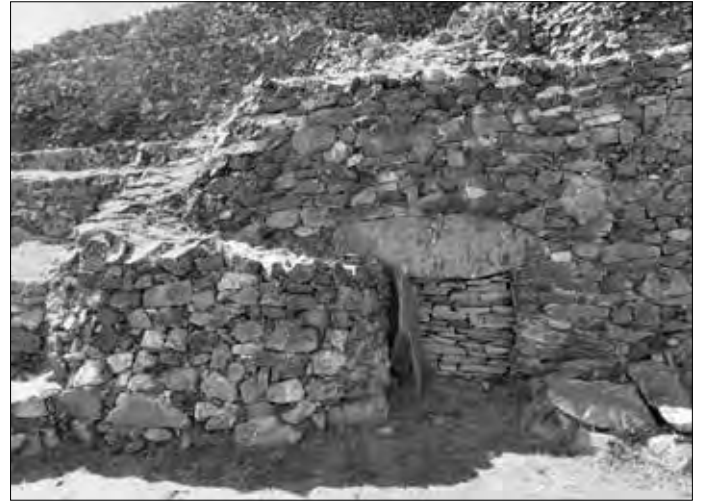
Bild 6d: Eingang Südwest.
