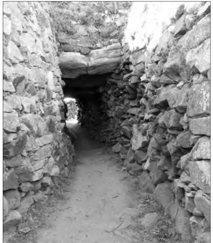
Bild 6f: Eingang Südwest, frei zugänglich.
