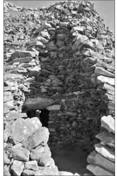
Bild 10: Gewölbekammer aus Bruchstein.
