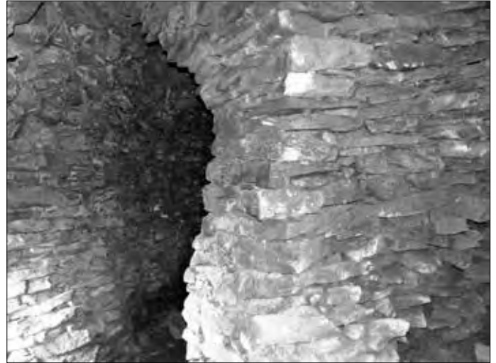
Bild 19: Eine Mittelwand teilt den Raum.
