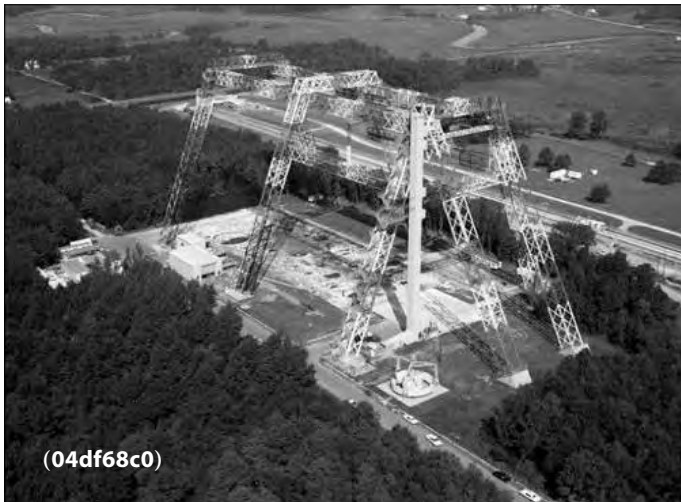
Der große Traversenkran, mit dem die Landung von Landefähren auf dem Mond simuliert wurde.
