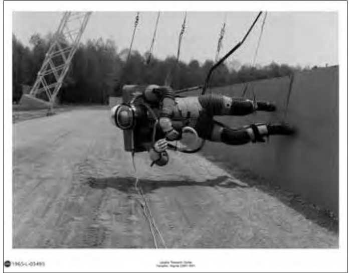
Links: Ein sogenannter „Takeoff-Simulator“. Rechts und unten: Astronauten an Gummibändern üben unter simulierter Mondgravitation.
