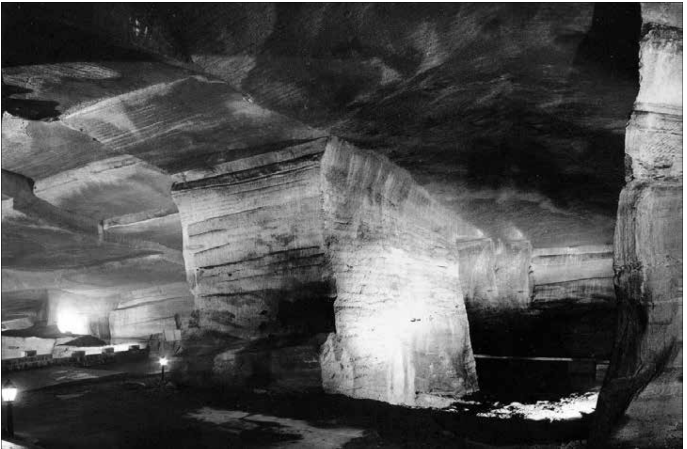
Abb. 2 – Manche der gewaltigen Stützpfeiler weisen die Dicke eines Einfamilienhauses auf.
