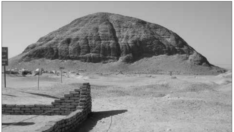
Die Hawara-Pyramide von Pharao Amenemhet III. wurde ebenfalls aus luftgetrockneten Schlammziegeln errichtet. Man kann sich nur wundern, dass heute überhaupt noch etwas von ihr steht!
