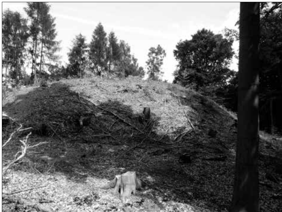
Bild 12: Eingebauter Wasserbehälter im Poppenwald.
