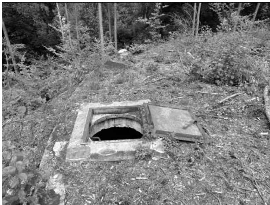
Bild 13: Einstieg in den Wasserbehälter.
