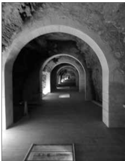
Blick in den Hauptgang mit seinen gemauerten Stützen, dem Holzfußboden und den darin eingelegten Fenstern.
