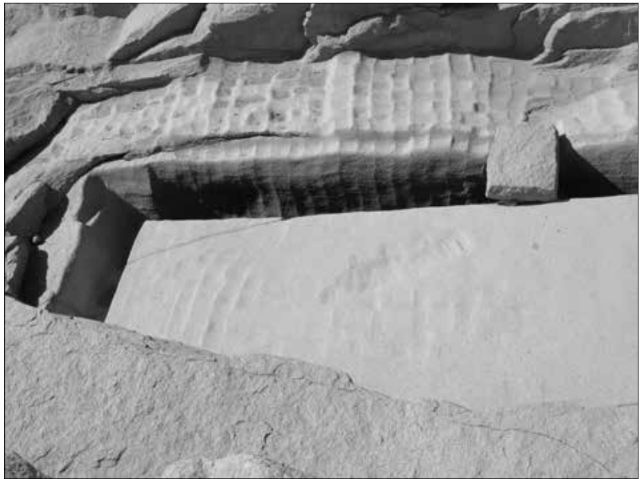
Der sogenannte unvollendete Obelisk im Granitsteinbruch in Assuan. Man erkennt insbesondere im umliegenden Bereich, dass das (ehemals weiche oder weich gemachte) Gestein regelrecht abgeschabt wurde.
