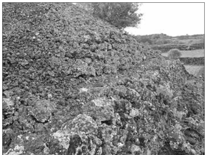
Eine Terrassenstufe oberhalb des gewölbten Daches.
