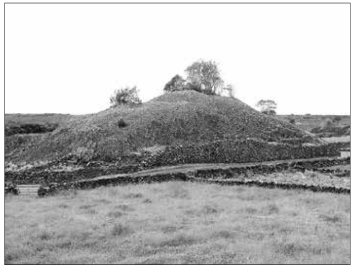
Man sieht hier deutlich den Verfall. Es müssen einst die Stützmauern gut erhalten gewesen sein und die Pyramiden mit dem Ziel gebaut worden sein, ordentliche Außenmauern und Strukturen aufzuweisen. Das Aussehen als regelloser Lesesteinhaufen war nicht geplant. Man sieht daher bei allen Strukturen noch Ansätze zu ordentlichen Außenmauern, Terrassen und Aufgängen und gezielt angelegten Formen.
